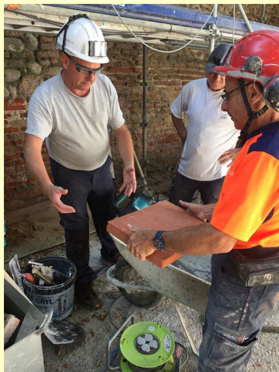
Prêts pour le harpage : l'inclusion dans l'édifice de briques afin de le consolider.
