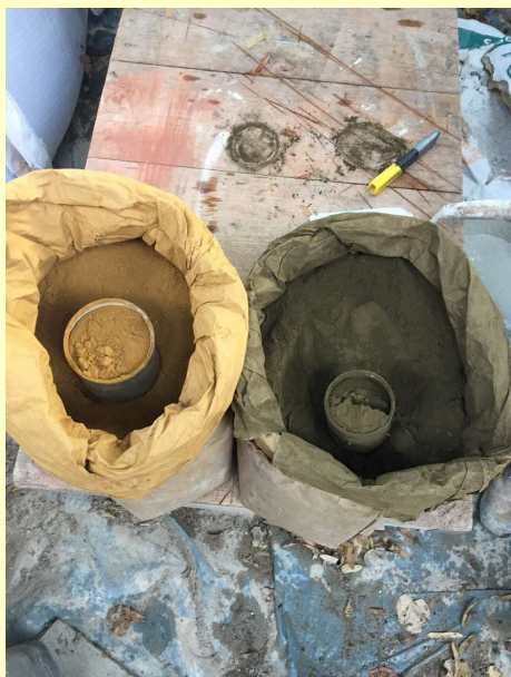
Terre de sienne naturelle et terre d'ombre naturelle : deux pigments qui seront intégrés dans la chaux qui sera enduite sur les murs.
